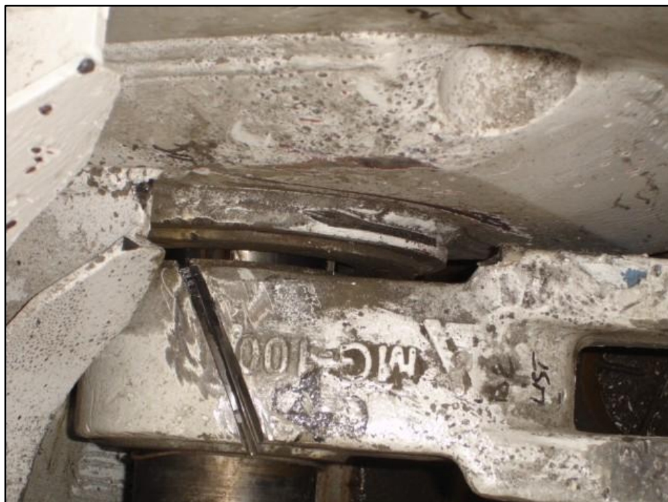
Découpage charnières porte AR – Punching of transom door's hinges
